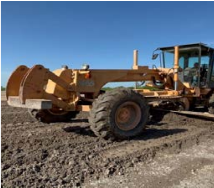
Escarificación o Pulverización de un suelo con Motoniveladora
