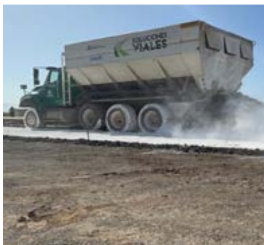
Figura 22. Aplicación de Hidróxido de Calcio Hidrovial+ con camión esparcidor
