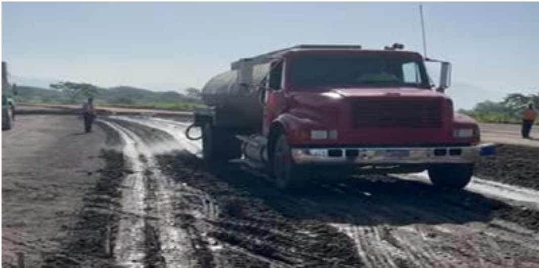
Figura 25: Aplicación de agua en una mezcla de suelo y estabilizante.
