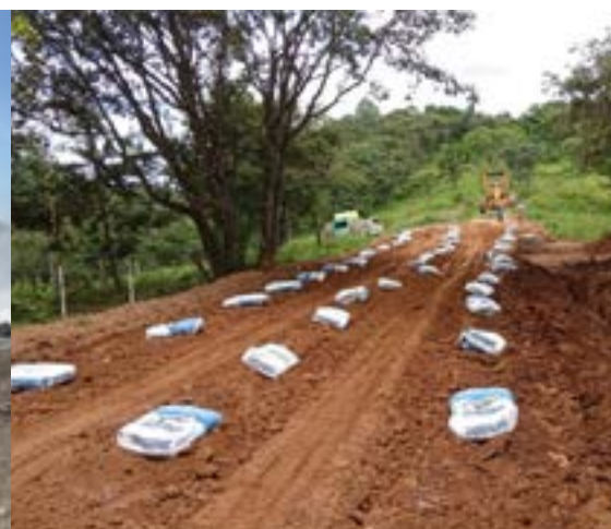
Figura 31. Aplicación de Hidróxido de Calcio Hidrovial+ por medio de sacos de 25 Kg.
