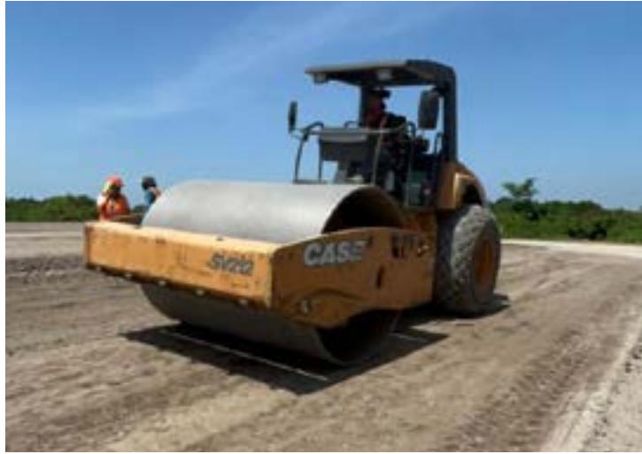
Figura 26. Compactación con vibro compactador pata de cabra y rodo vibratorio
