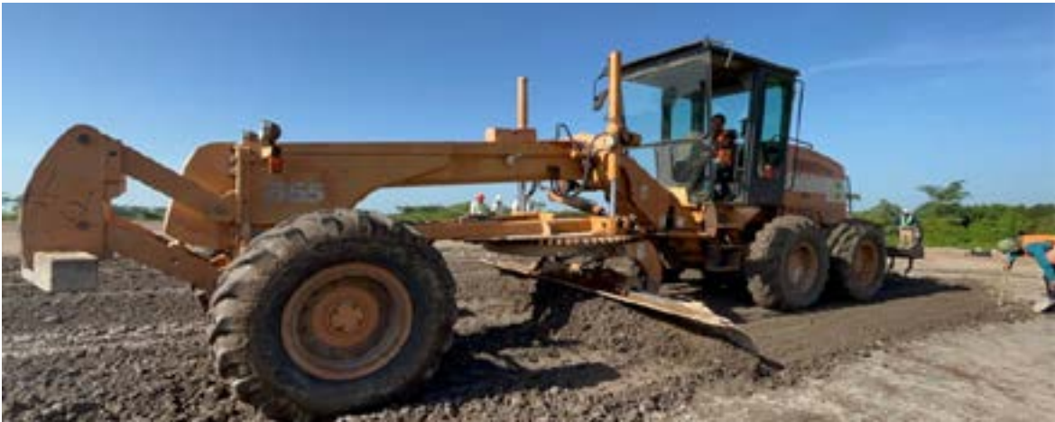
Figura 26. Mezcla y pulverización final de suelo y estabilizante
