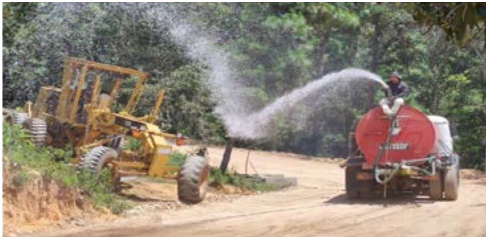
Figura 27. Curado de un suelo estabilizado con Hidrovial+
